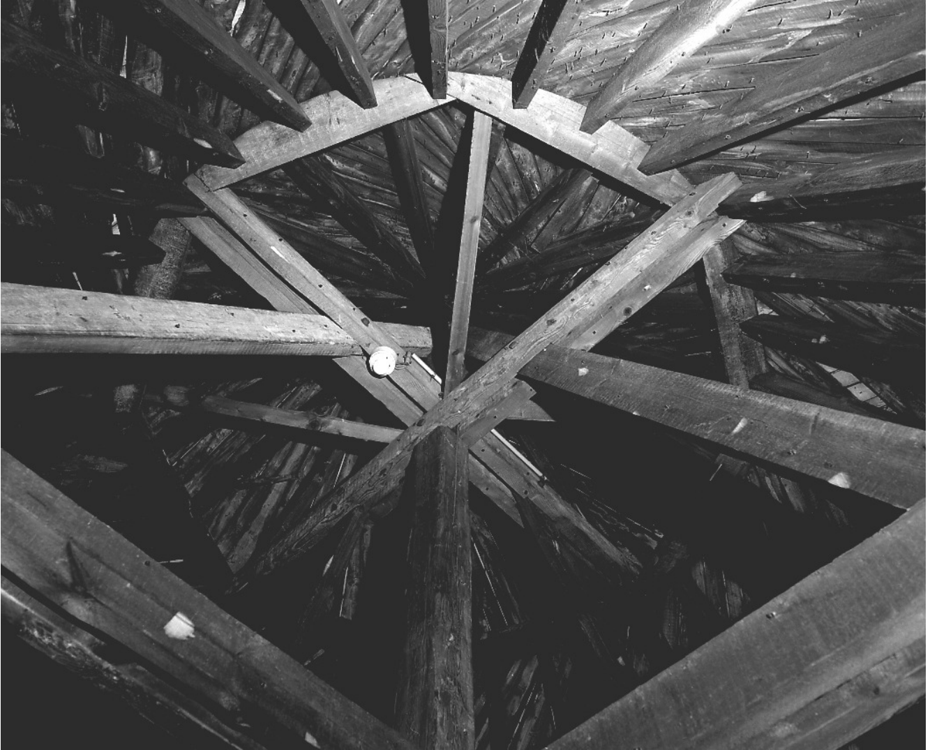
Fig.16 Charpente du dôme de la tour d'escalier.
