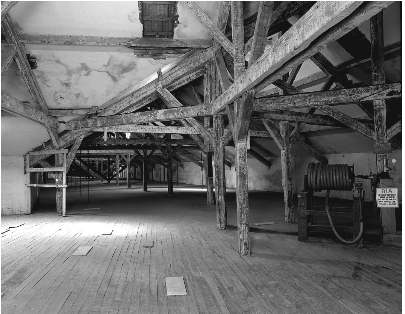
Fig.15 Etage de comble de l'aile Nord des ateliers : charpentes.
